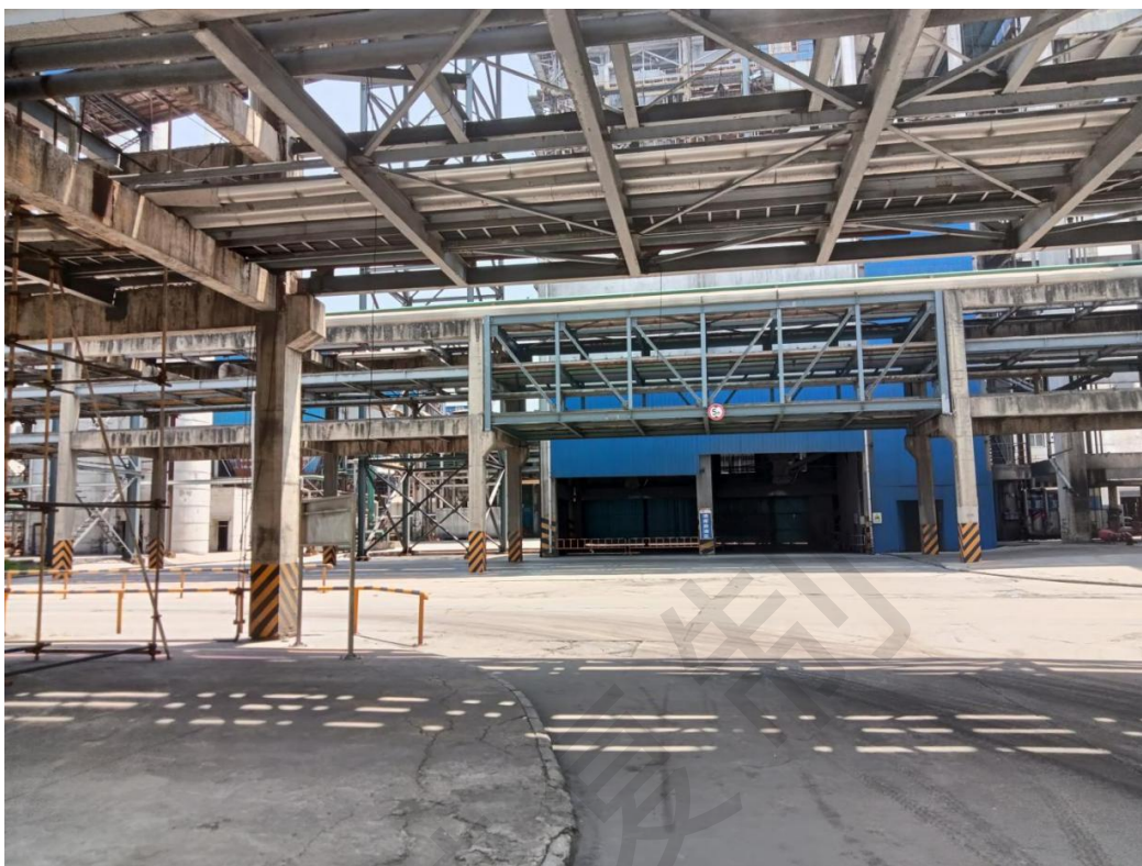
图1 东侧厂内运输道路
