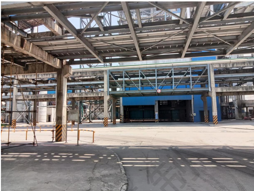
图 2-3 东侧厂内运输道路
