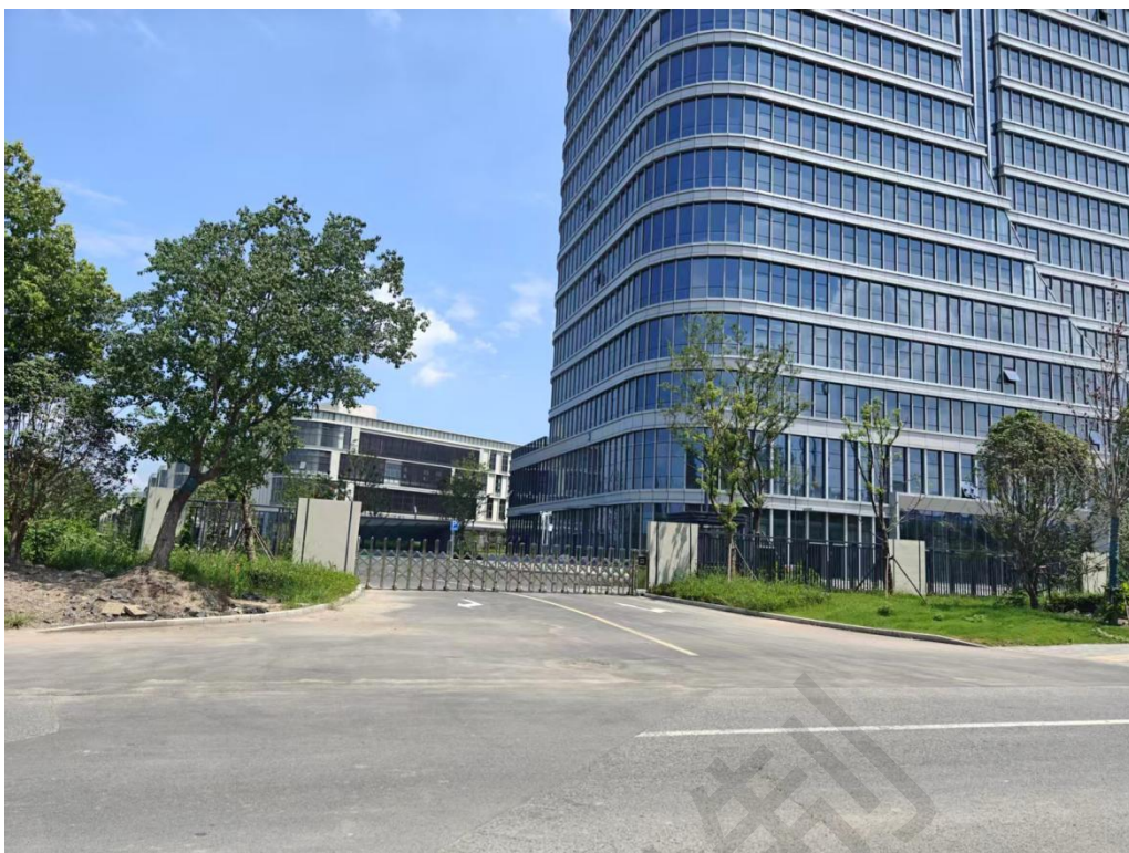
图 2-7 项目东侧北湾科技双创园 1 期(建设中)
