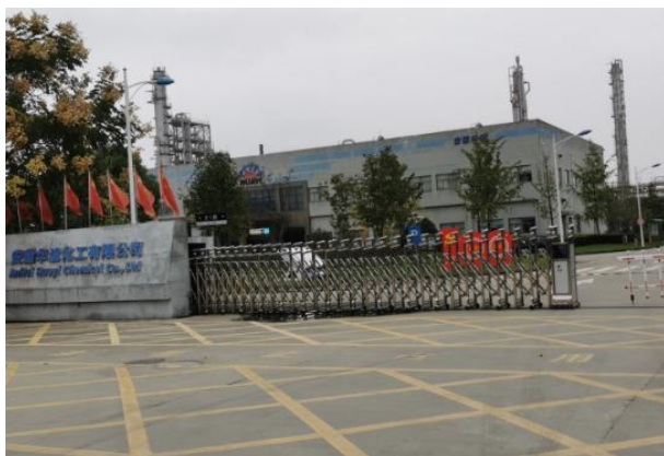
项目南侧淬剑路及华谊集团公司生产厂房
