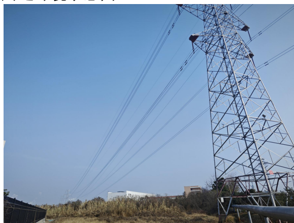
(2) 东南侧 39m 高 220kv 高压电力线
