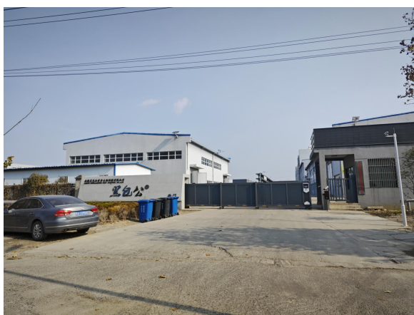
(1) 西侧为安徽黑包公有害生物防控有限公司
