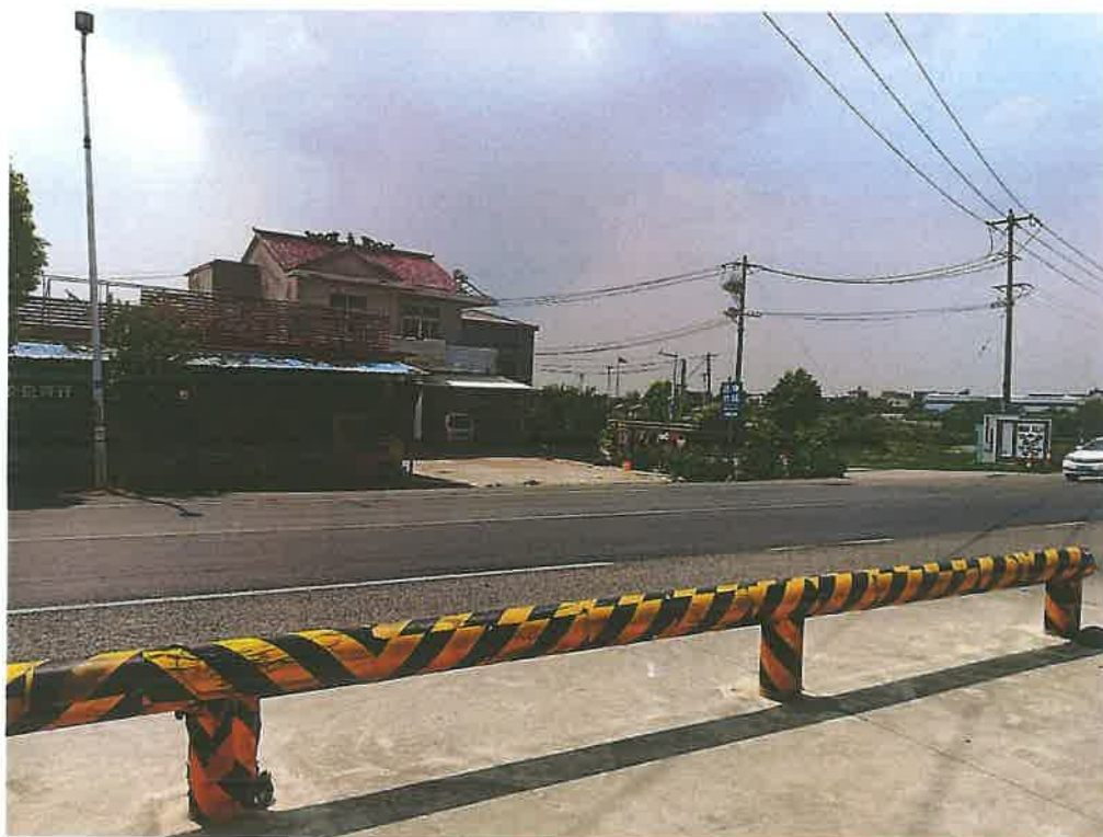
图 3 项目东侧 G347 国道、民房区和架空电力线
