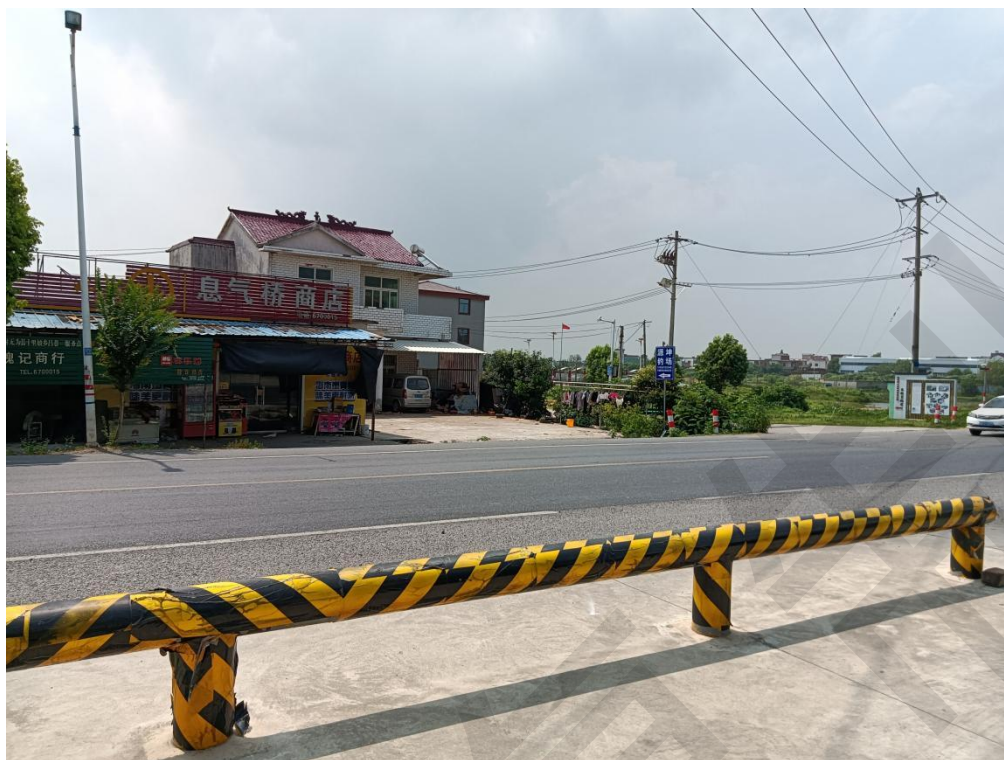
图 2-6 加油站东侧 G347 国道、民房区和架空电力线
