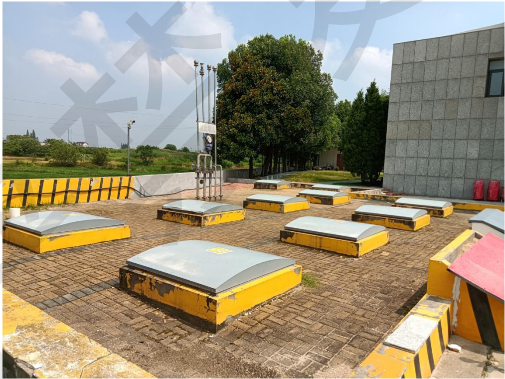
图 2-12 加油站罐区照片
