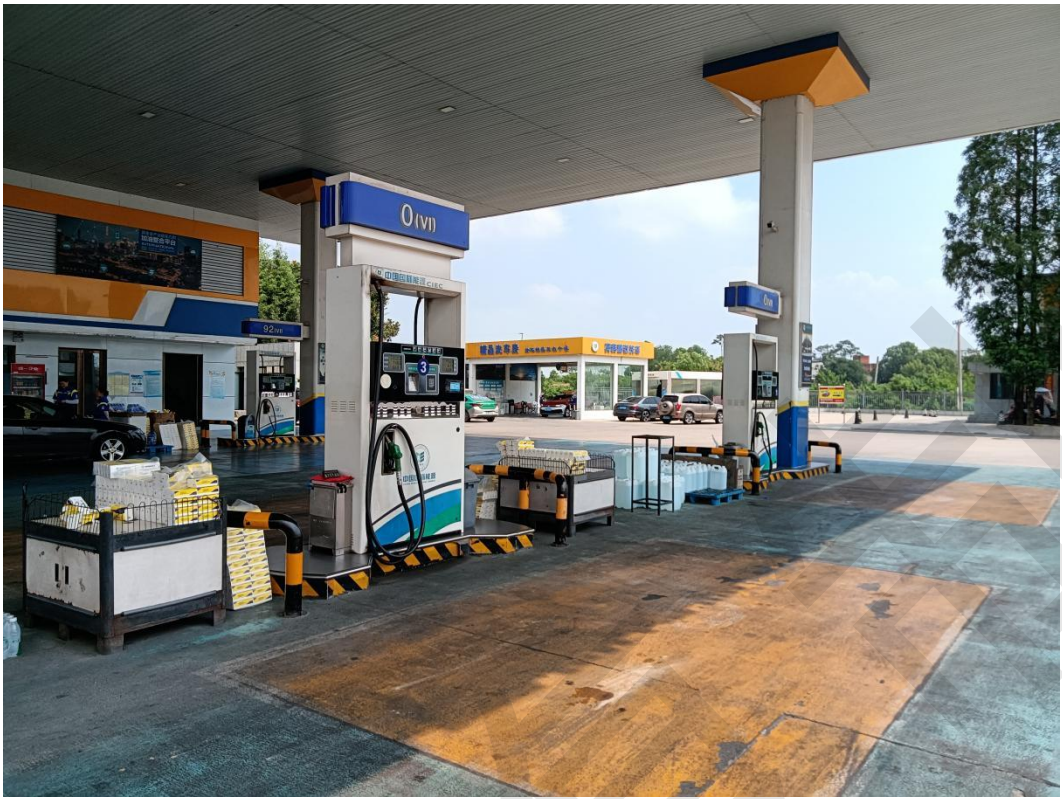
图 2-11 加油站加油区照片
