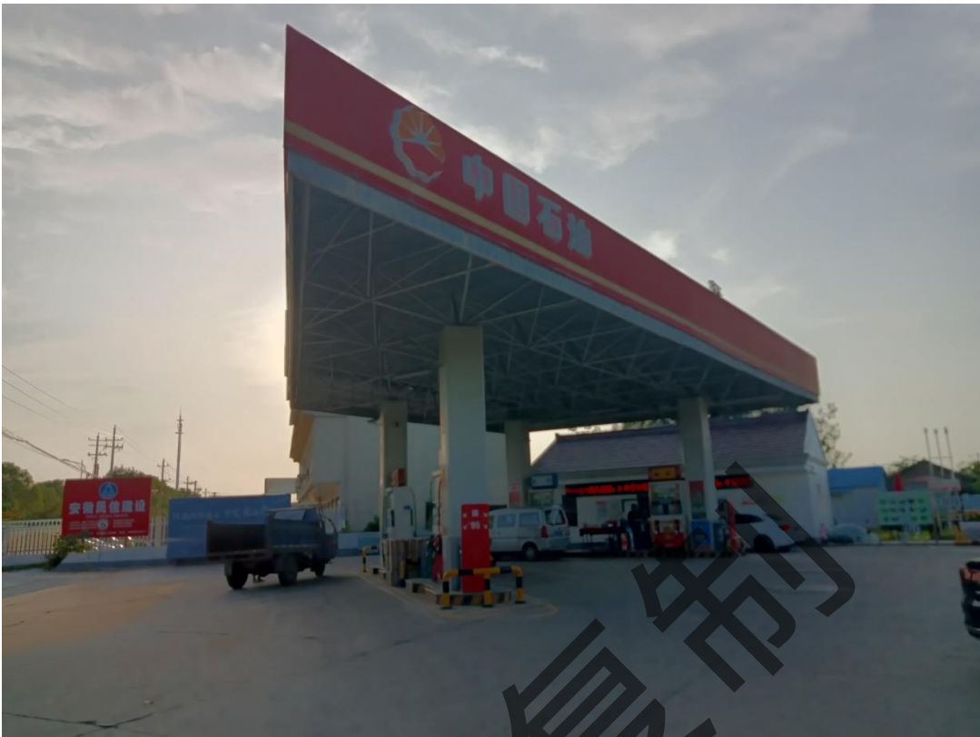
加油站全景照片
