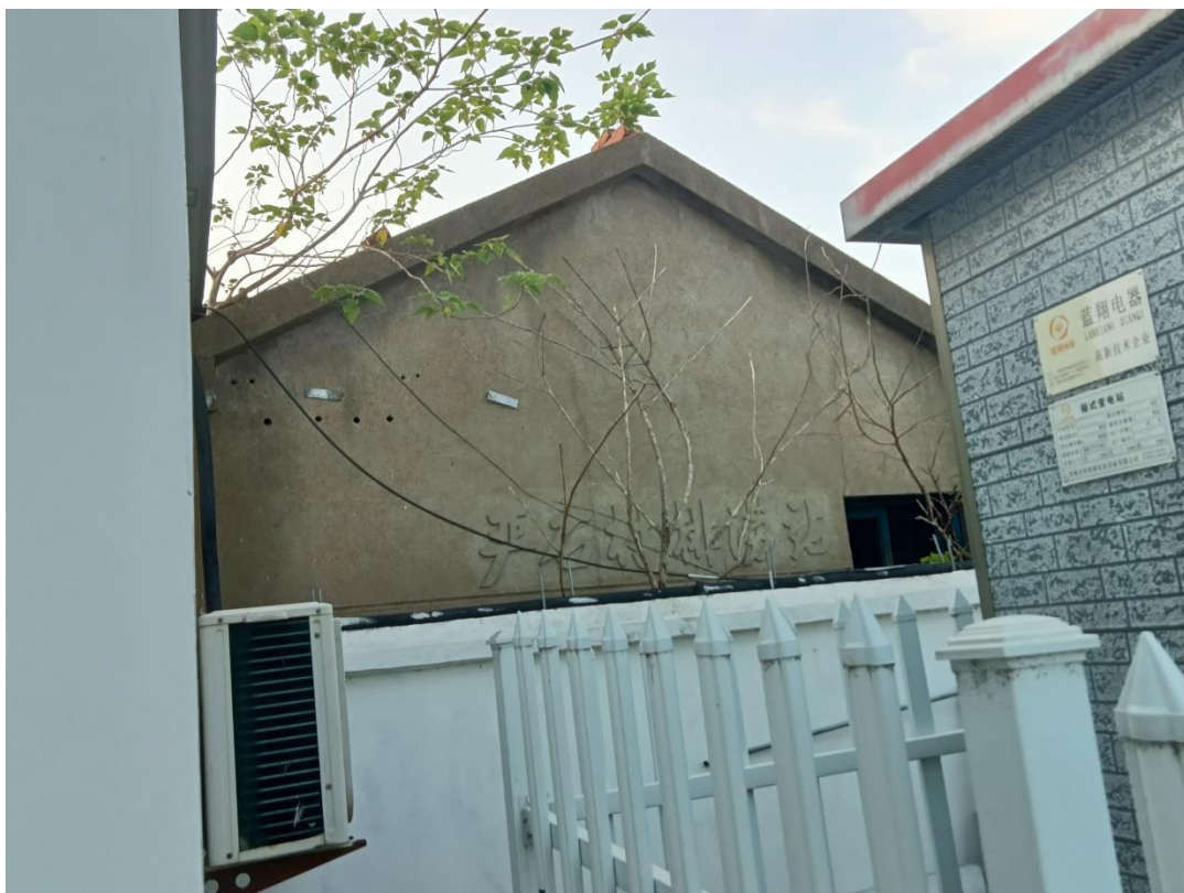
图 7 项目北侧排涝站（废弃）和树林
