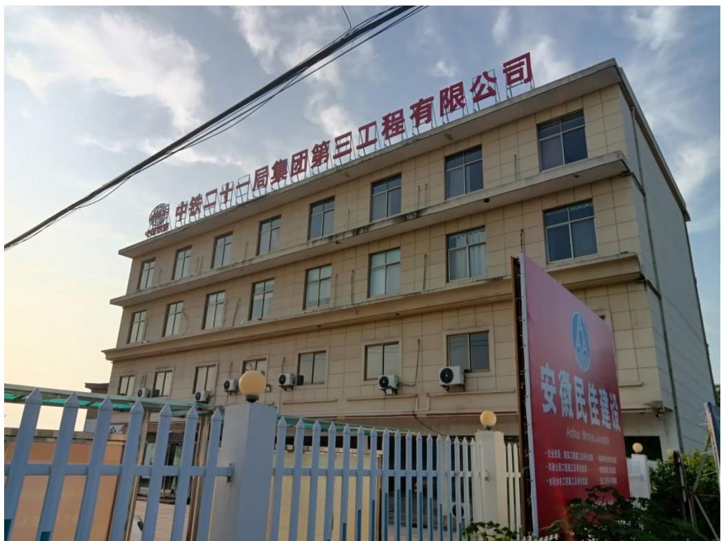
图6 项目西侧民房和中铁二十一局集团第三工程有限公司
