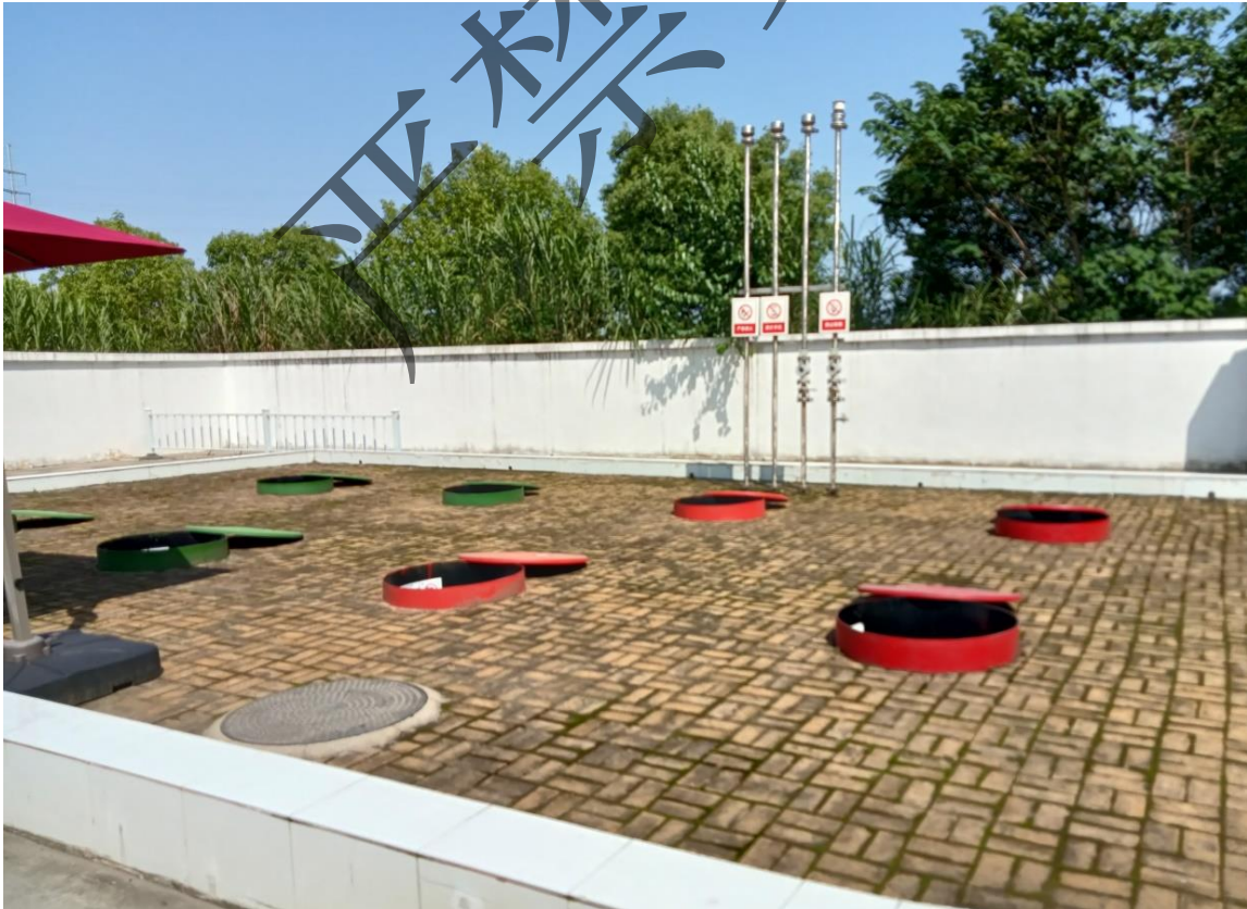
加油站罐区照片
