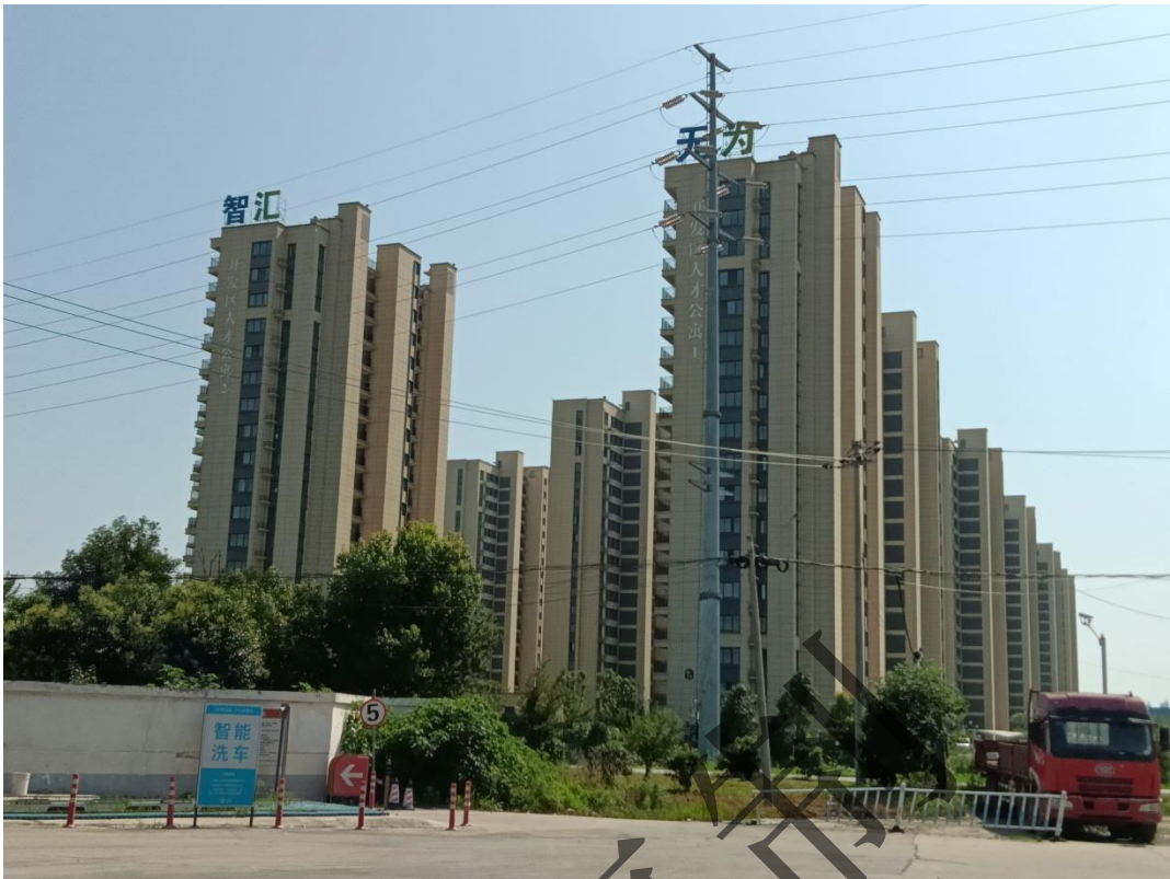
图 2-8 加油站西侧为架空通信线路、架空电力线路（杆高 12m）、架空电力线路（杆高 45m）、允长路和开发区人才公寓
