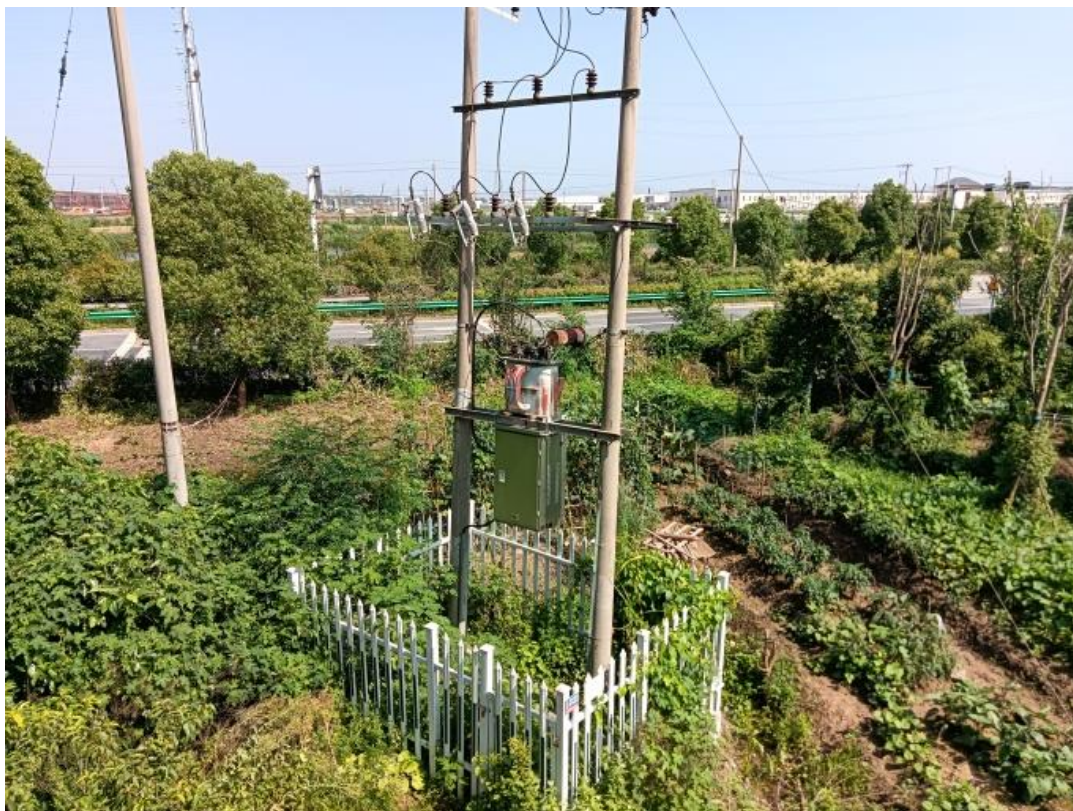
图 5 项目南侧树林、杆式变压器和通江大道
