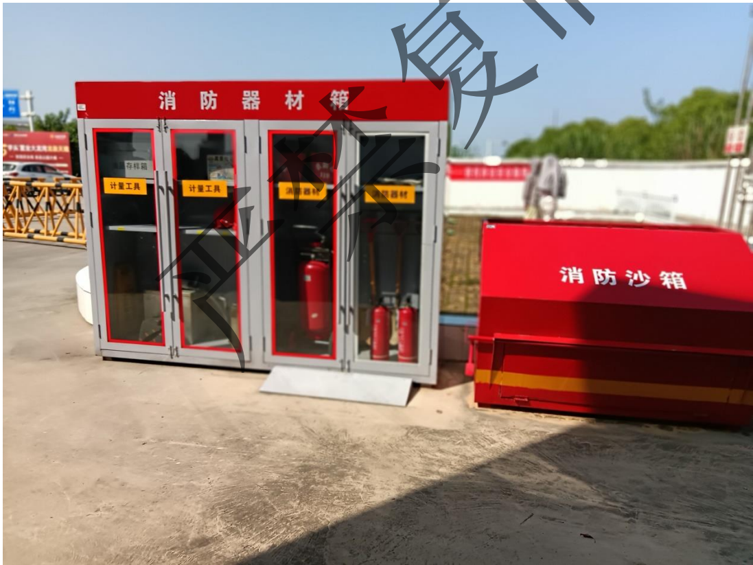
图 2-12 消防器材箱和消防沙箱
