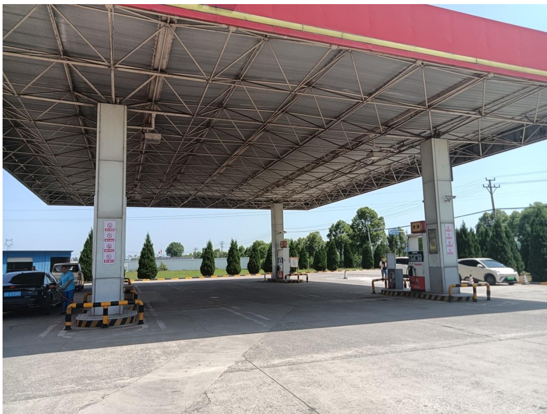
加油站全景照片
