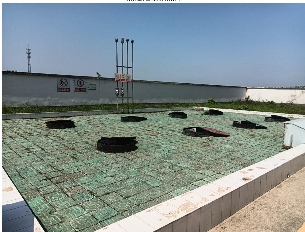
加油站罐区照片
