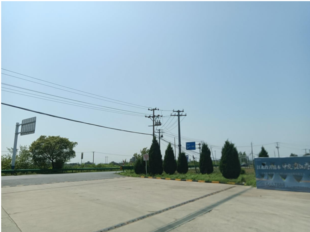
图 6 项目西侧架空电力线、架空通信线和 S213 省道
