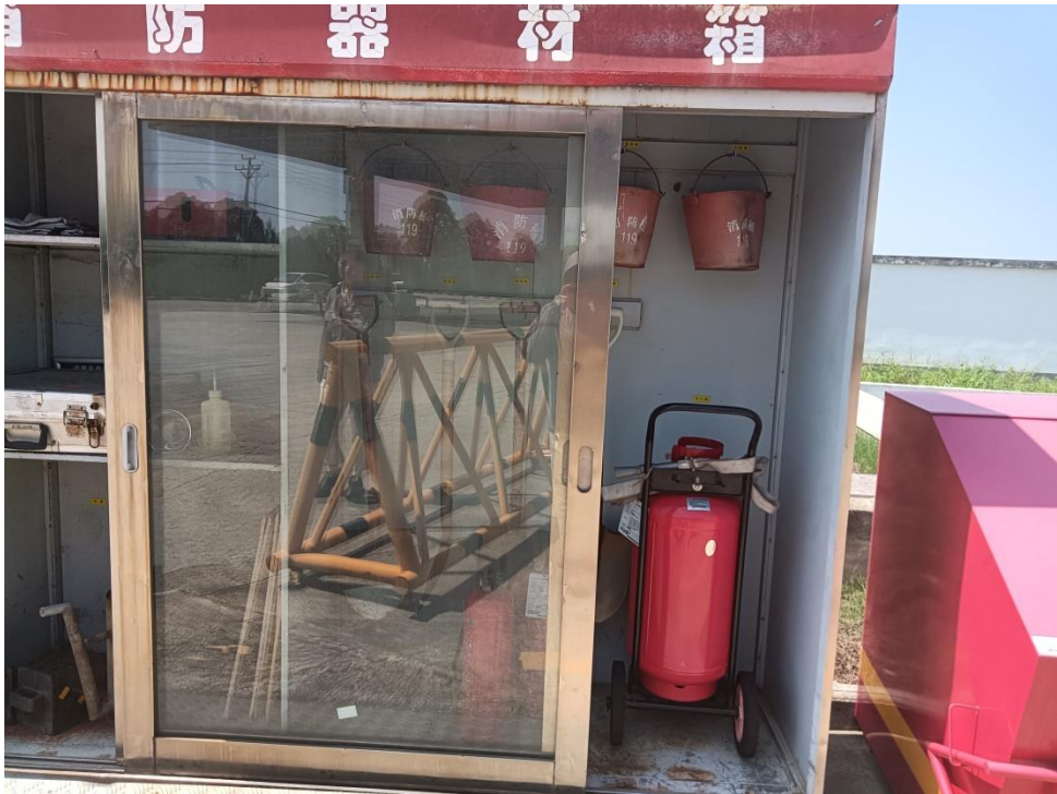
图 2-12 消防器材箱和消防沙箱
