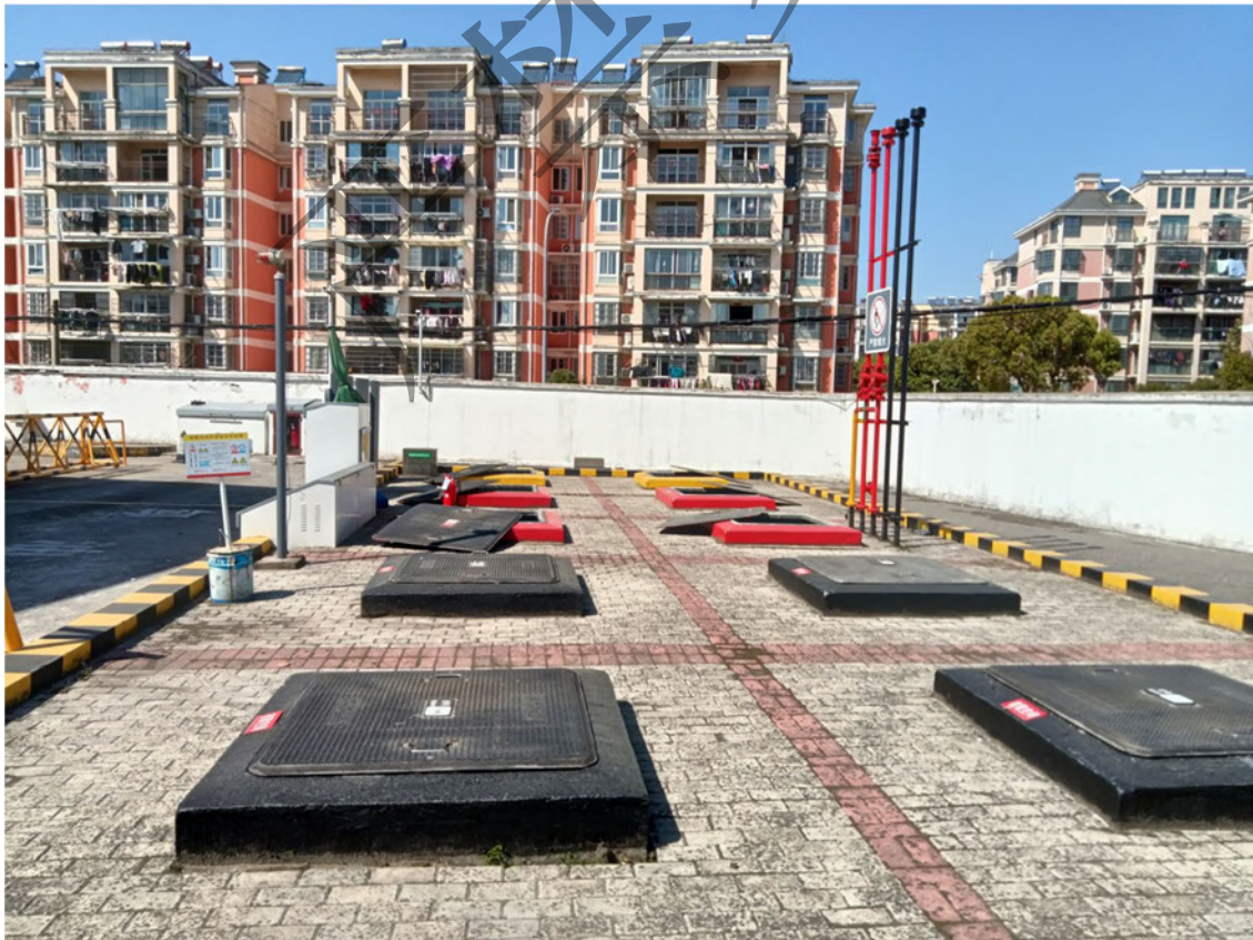
加油站罐区照片
