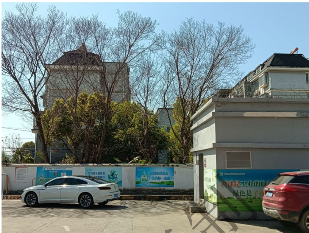
图 2-10 加油站西侧为龙湖花园 5 层居民楼和一路架空电力线路
