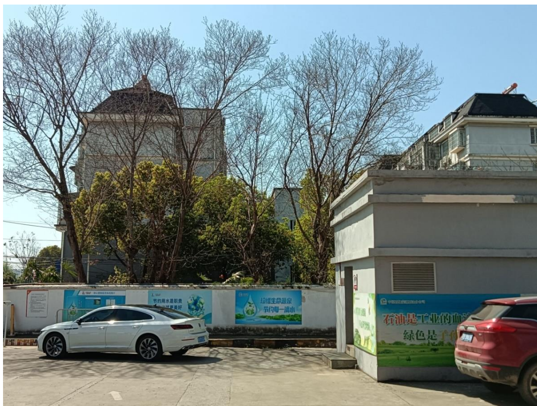
图 6 项目西侧龙湖花园 5 层居民楼和架空电力线路
