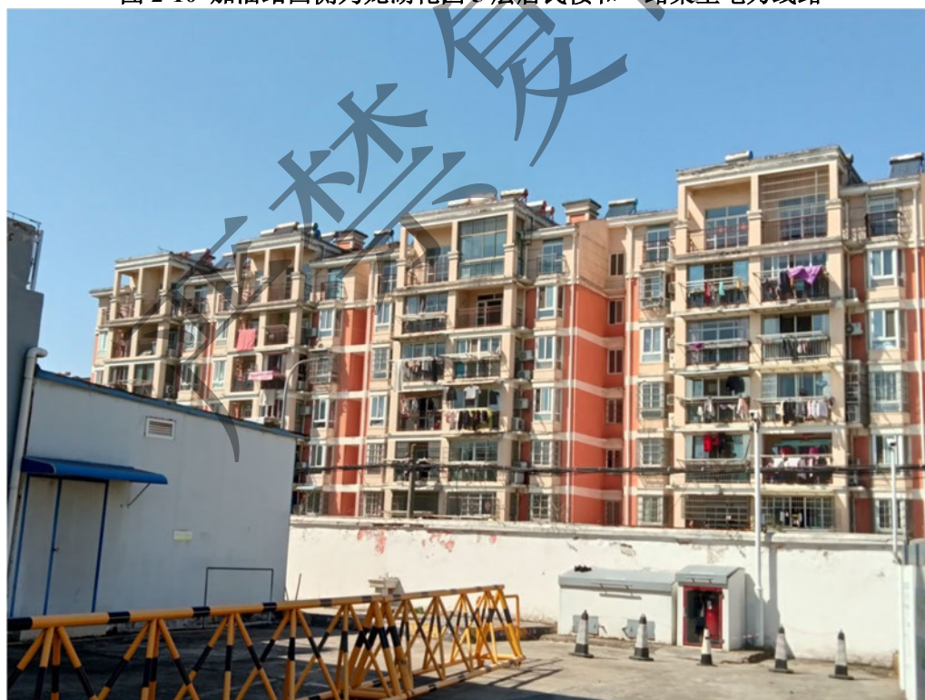
图 2-11 加油站北侧为幸福花城 6 层居民楼和一路架空通信线路
