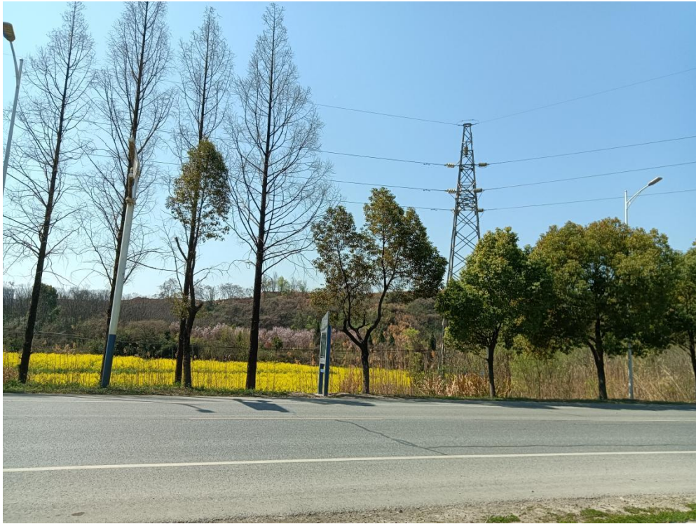
图 5 项目南侧 S335 省道及架空电力线路
