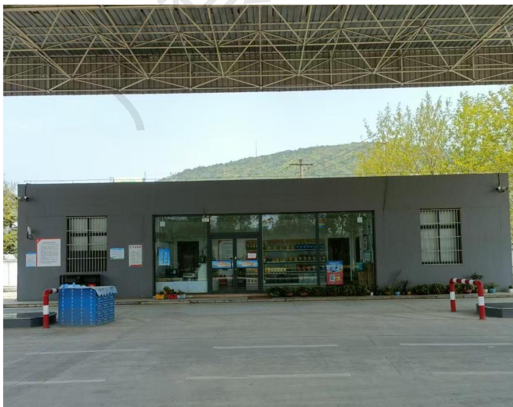
图 2-12 加油站站房照片
