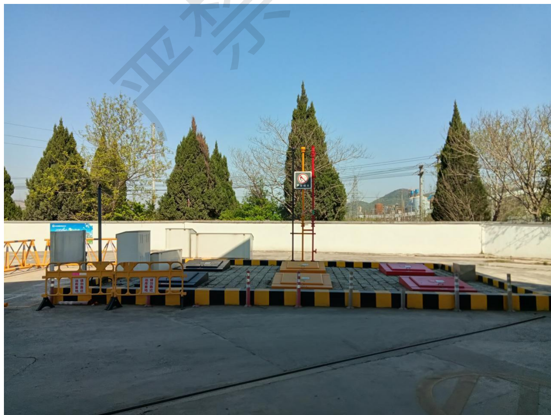
加油站罐区照片
