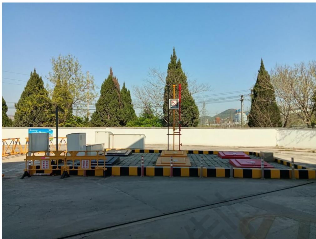
图 2-13 加油站储罐区照片
