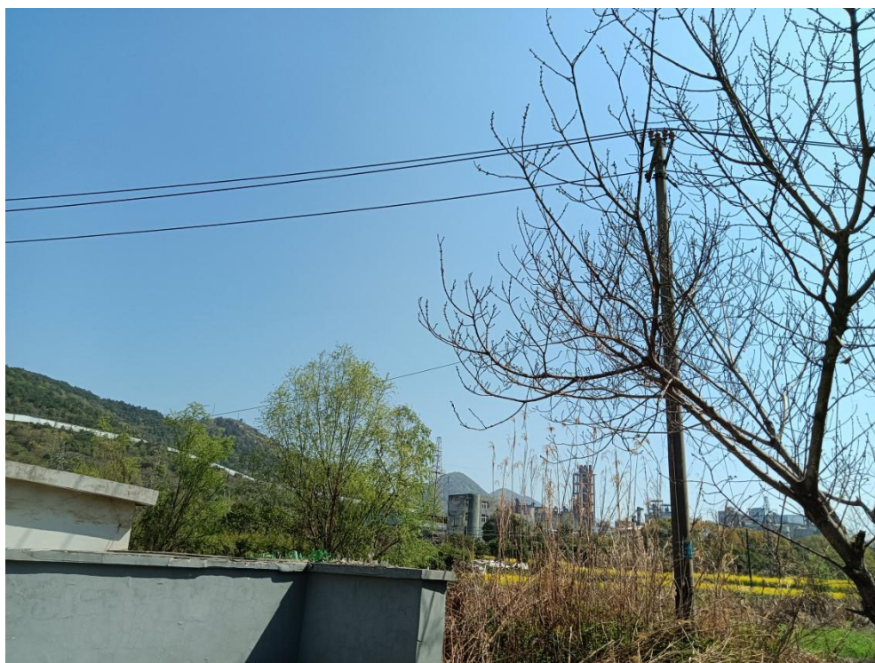
图4 项目东侧架空通信线路
