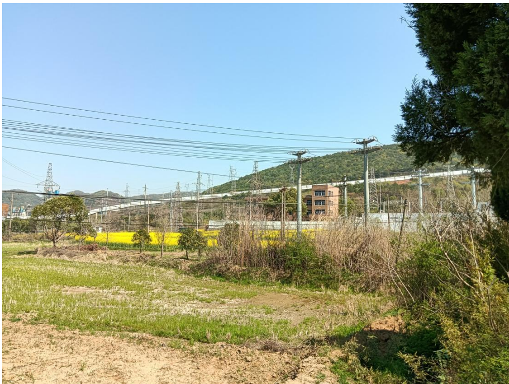
图 6 项目西侧架空电力线路
