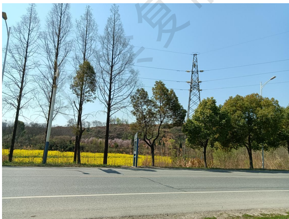
图 2-7 加油站南侧 S335 省道及架空电力线路
