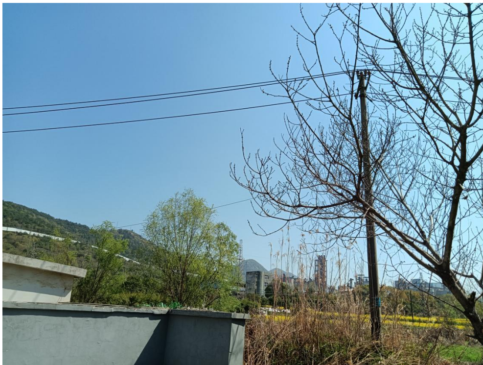
图 2-6 加油站东侧架空电力线路
