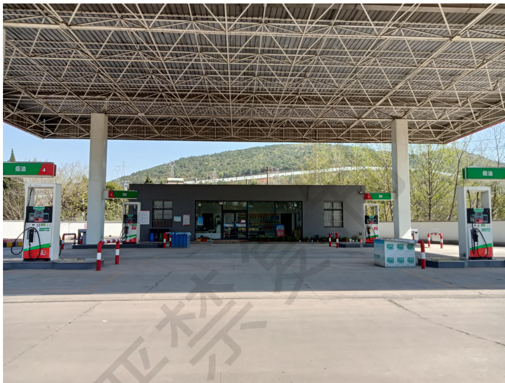
图2-10 加油站全景照片
