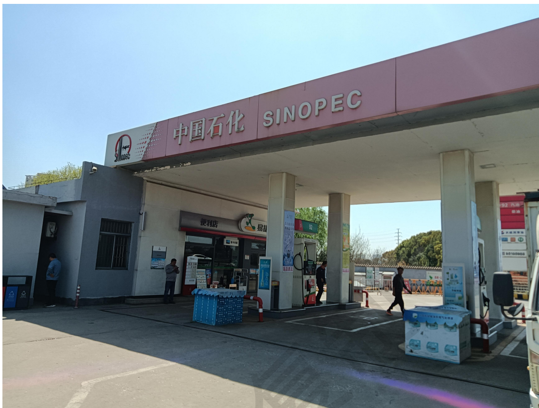
加油站全景照片
