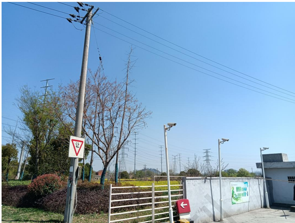
图 2-6 加油站东侧架空电力线路及空地
