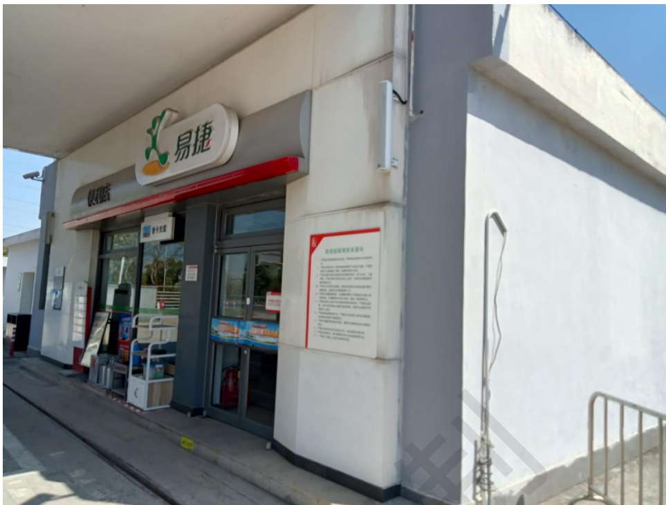
图 2-12 加油站站房照片
