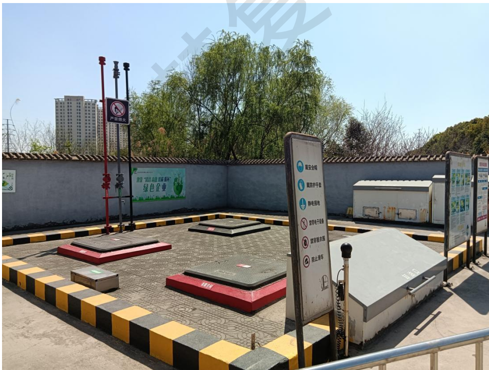
图 2-13 加油站储罐区照片
