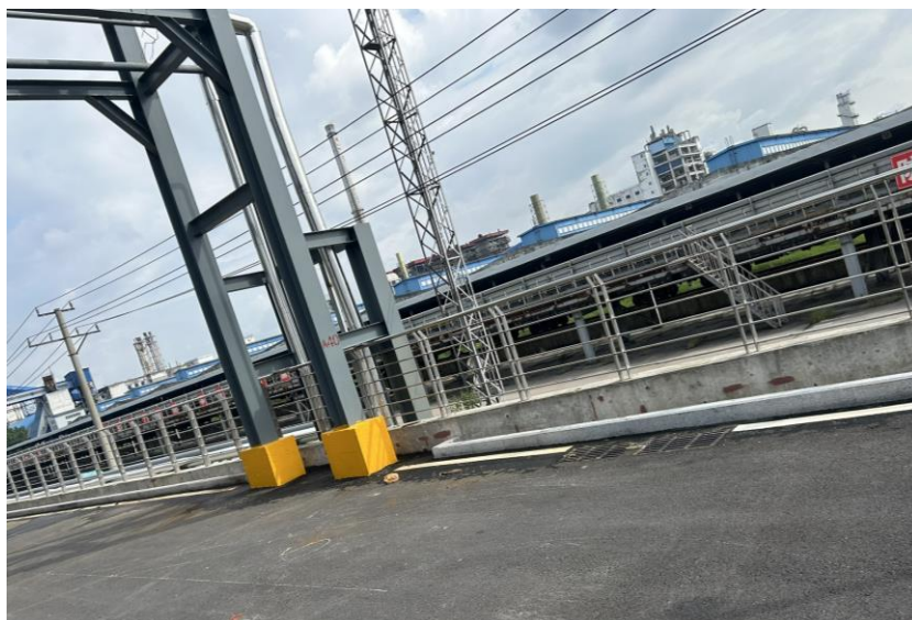
图 2.4-4 南侧中盐安徽红四方股份有限公司铁路专用线
