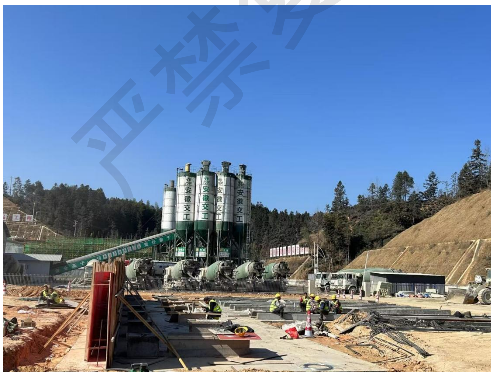
图 1.5 项目西南侧充电箱变及充电车棚（在建）
