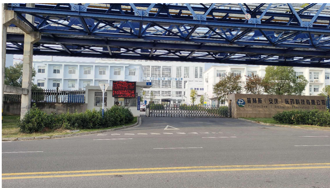
图 2-6 北侧园区管廊及普林斯（安庆）医药科技有限公司
