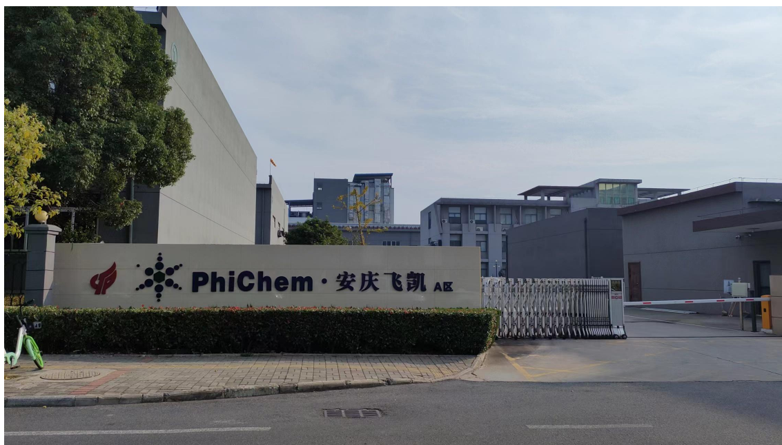
图 2-4 南侧飞凯公司 A 区
