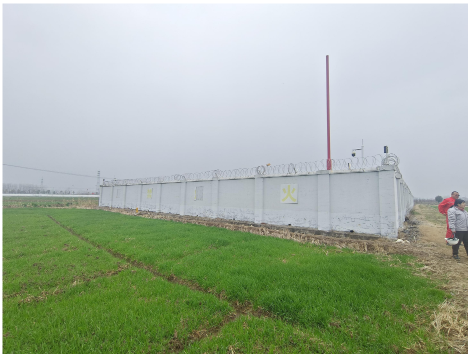
安庆市第二天然气门站（西侧）
