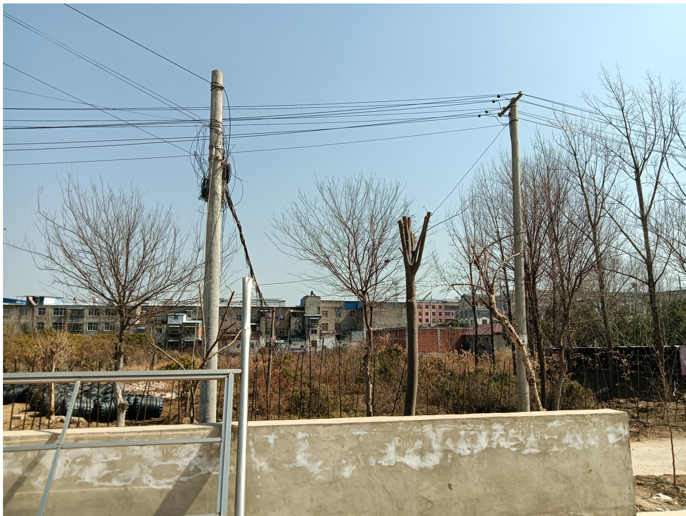
项目东侧 S4 公路及架空通信线和电线杆
