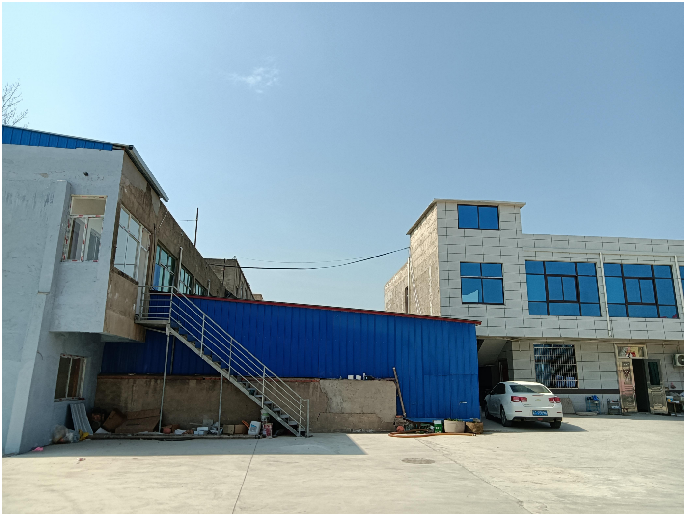
项目西侧三栋民建
